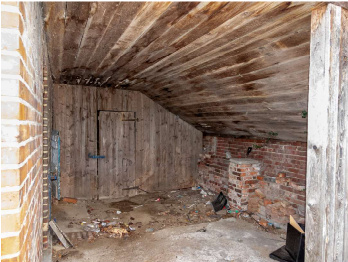
Ehem. Schweinstall. (Foto: DSCN0007)
