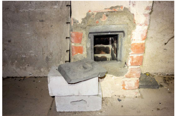
Nordwestlicher Schornstein. (Foto: _DSC5054)
