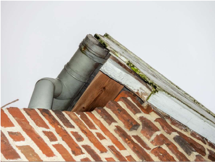
Spalt bietet Zugang zum Dach. (Foto: DSCN0012)
