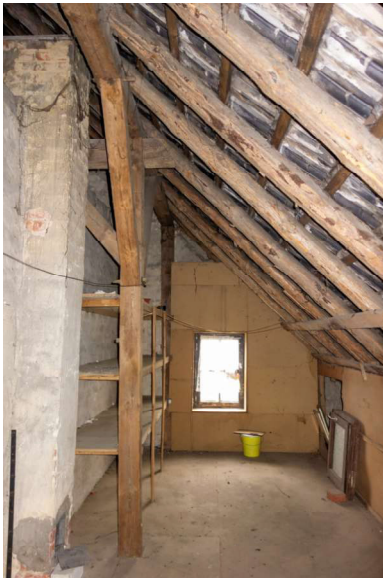
Dachboden. (Foto: _DSC5053)
