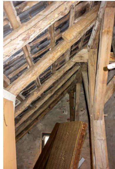
Dachboden. (Foto: _DSC5052)
