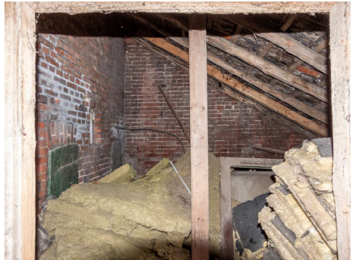
Raum hinter Schweinstall auf Nordseite. (Foto: DSCN0027)
