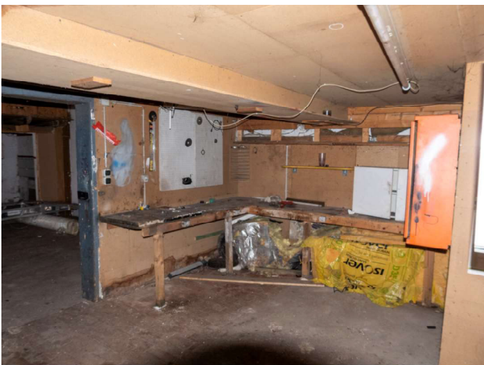
Nebenraum, vermutl. ehem. Stall. (Foto: DSCN0035)
