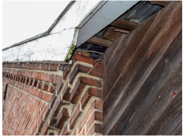
Zugang in den Dachbereich auf Ostseite. (Foto: DSCN0006)
