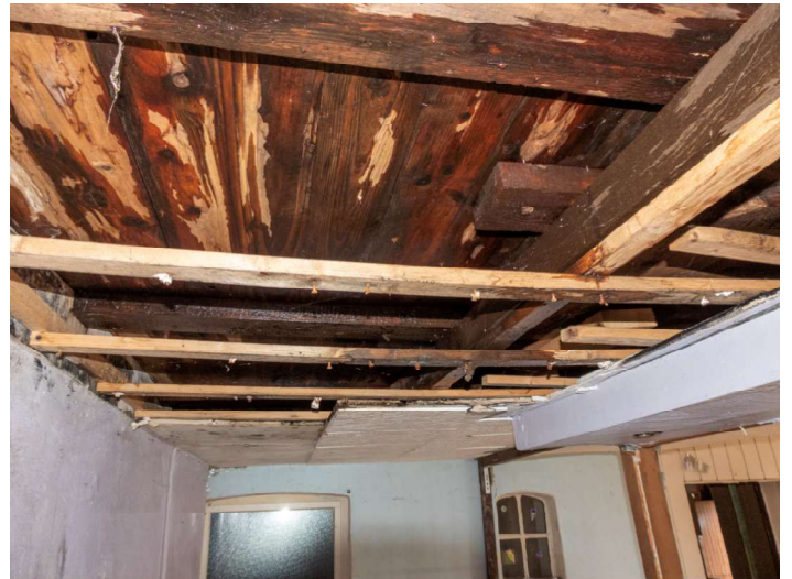
Zwischenboden hinter Stall. (Foto: DSCN0034)
