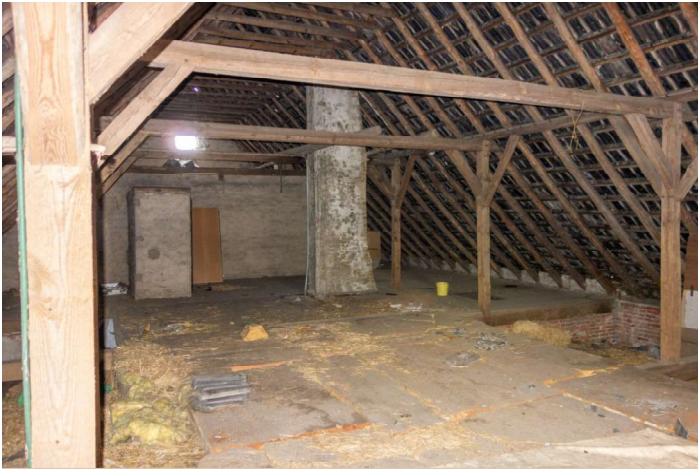
Großer Dachboden, Blick nach West. (Foto: _DSC5057)
