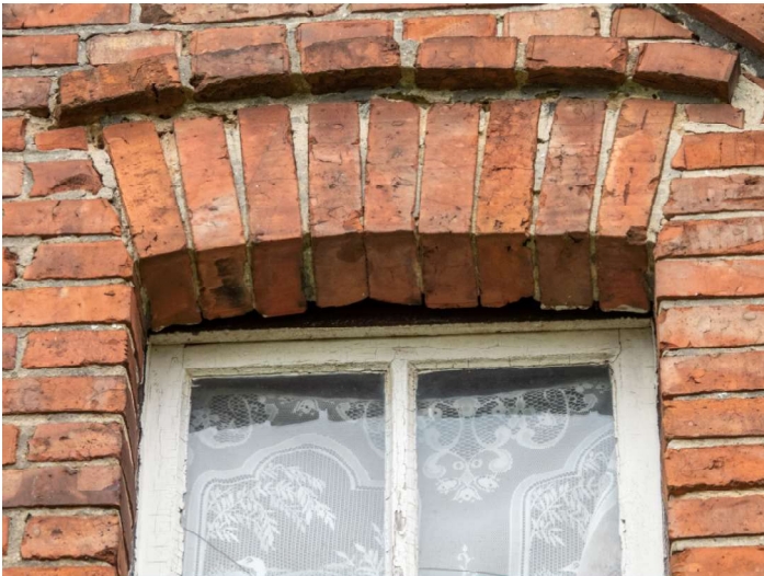
Spalt über Fenerrahmen bietet Zugang zum Haus. (Foto:
