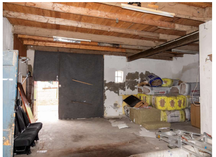
Großer Vorraum. Vermutl. ehem. Stall. (Foto: DSCN0029)
