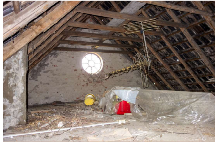
Empore auf Dachboden, westliche Seite. (Foto: _DSC5058)
