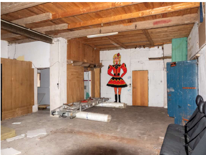
Großer Vorraum. Vermutl. ehem. Stall. (Foto: DSCN0028)
