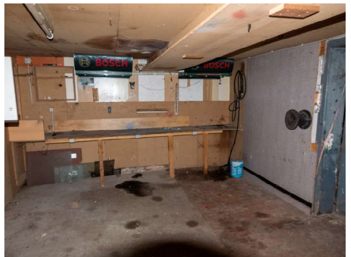
Nebenraum, vermutl. ehem. Stall. (Foto: DSCN0036)
