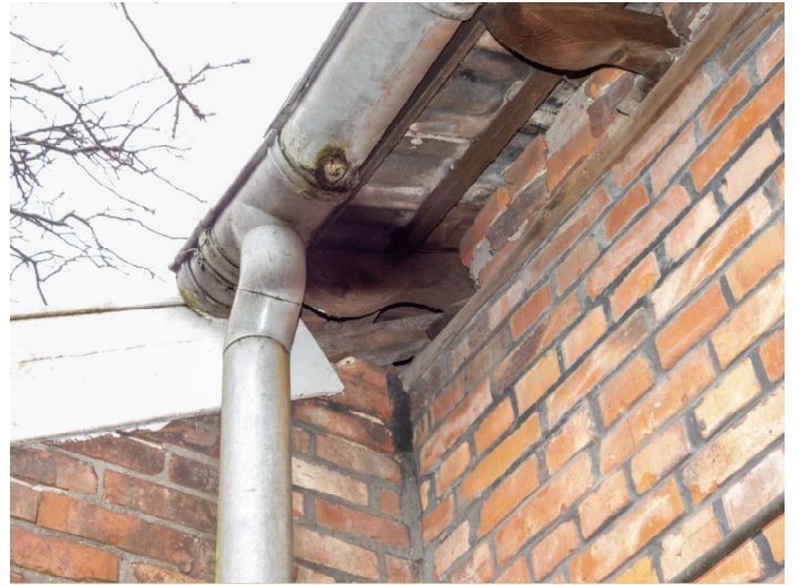
Weiterer Zugang in den Dachbereich. (Foto: DSCN0025)
