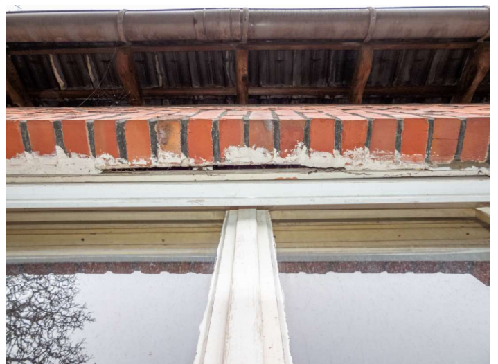
Zugang in den Rolladenkasten. Dieser lies sich zur Kontroll
