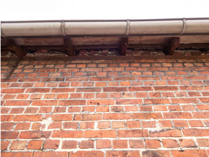
Zugänge zum Dach. (Foto: DSCN0014)
