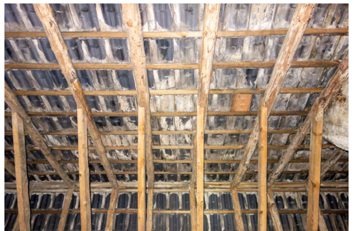
Gebälk im Dachboden. (Foto: _DSC5056)
