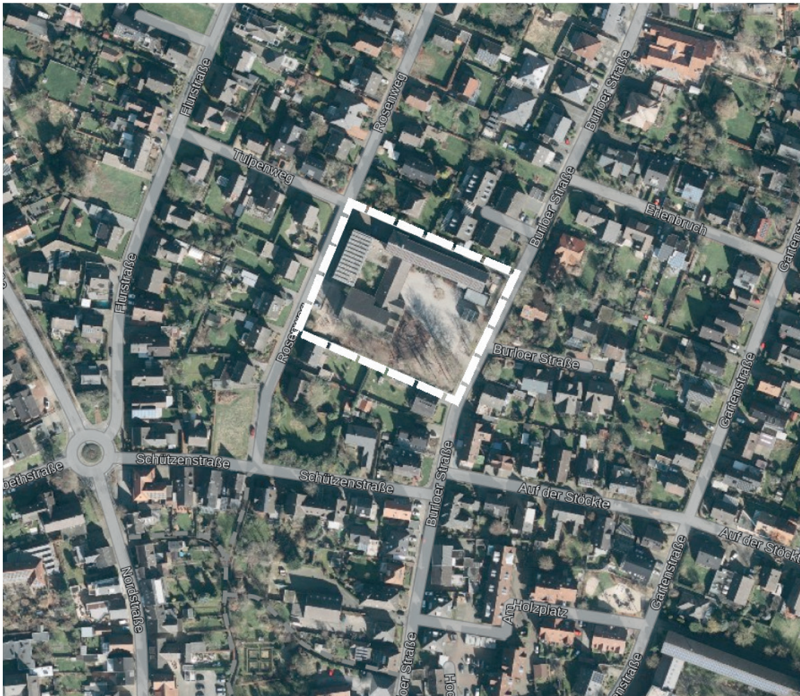
Abbildung 10: Bestehender Standort - Burloer Straße
